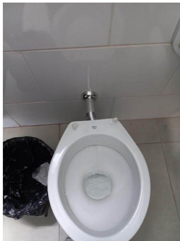
13/12 – substituição do conjunto de ligação ajustável vestiário feminino
