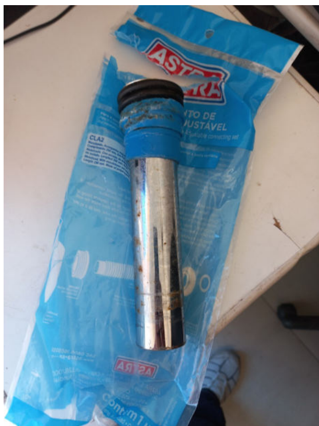
13/12 – substituição do conjunto de ligação ajustável vestiário feminino
