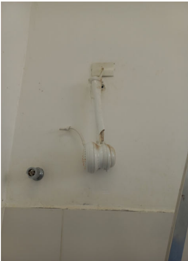
18/12 – substituição mangueira de ar comprimido ressecada leito 3.
